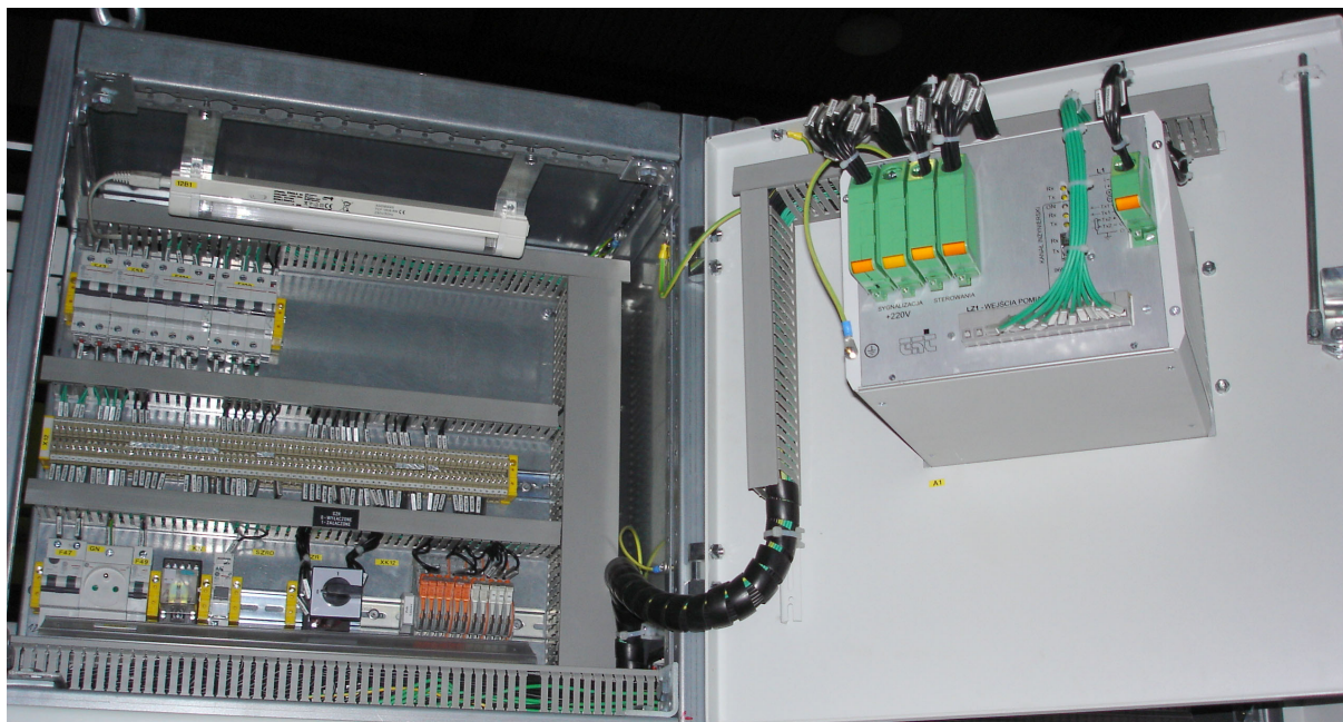
Rys. 1. Przedział obwodów pomocniczych
