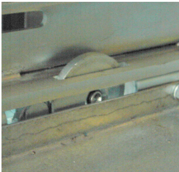
Rys. 10. Element mechanizmu blokady załączenia uziemnika gdy człon wysuwny jest w położeniu „praca”
