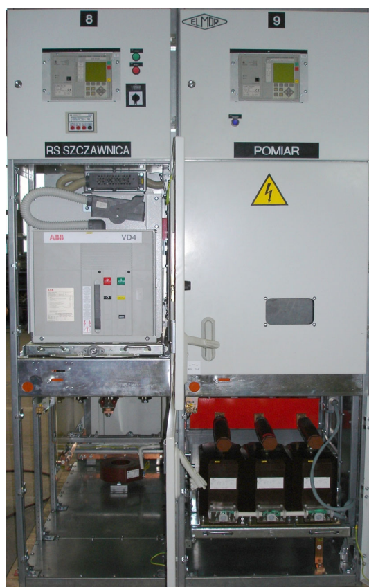
Rys. 5. Konstrukcja rozdzielnic WEGA
