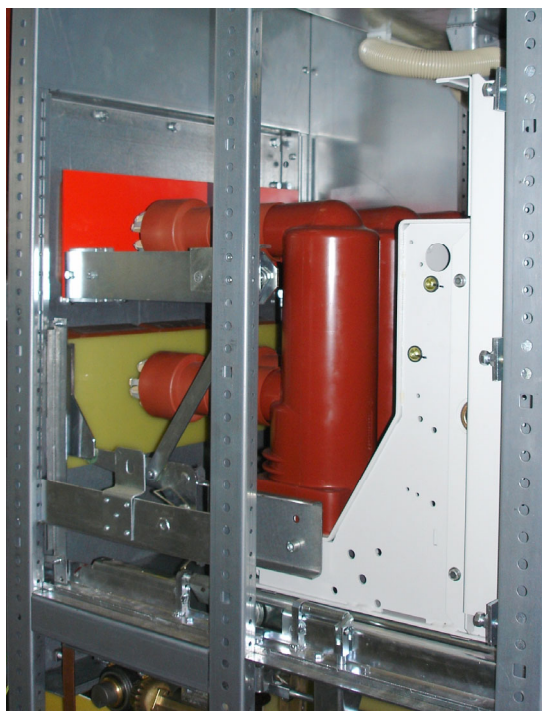
Rys. 3. Przedział członu wysuwonego
