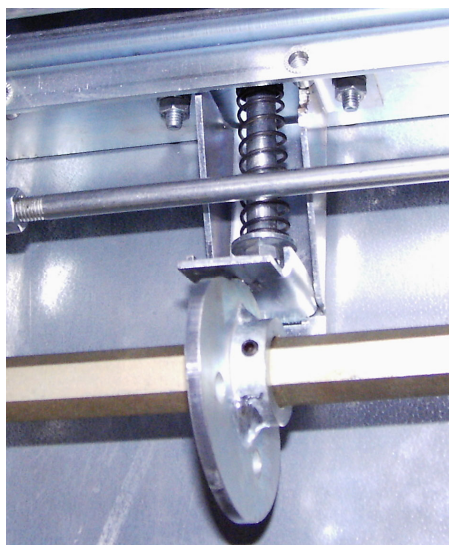
Rys. 9. Mechanizm wsunięcia członu wysuwnego do pozycji „praca” przy zamkniętym uziemniku i blokady załączenia uziemnika gdy człon wysuwny jest w położeniu praca.
