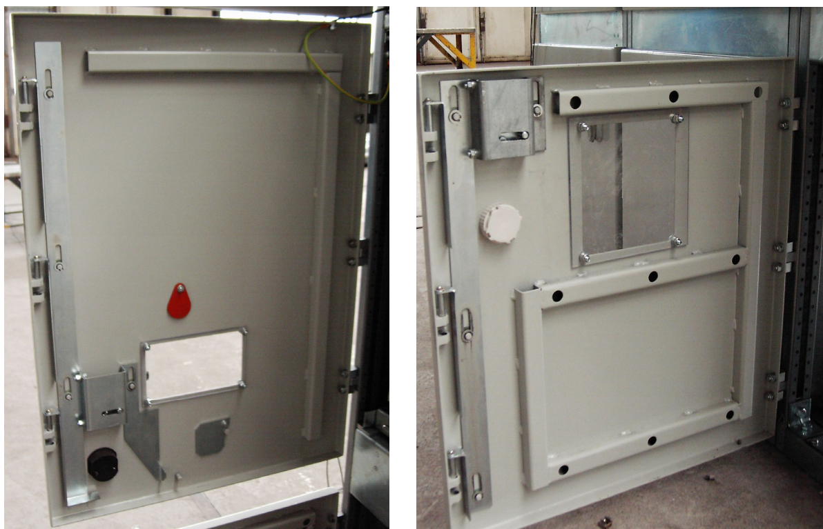
Rys. 12. Wzmocnienia oraz rygle wewnętrznej strony drzwi przedziałowych
