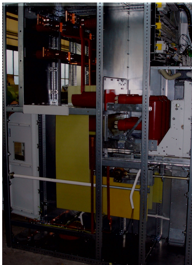
Rys. 5. Konstrukcja rozdzielnic WEGA
